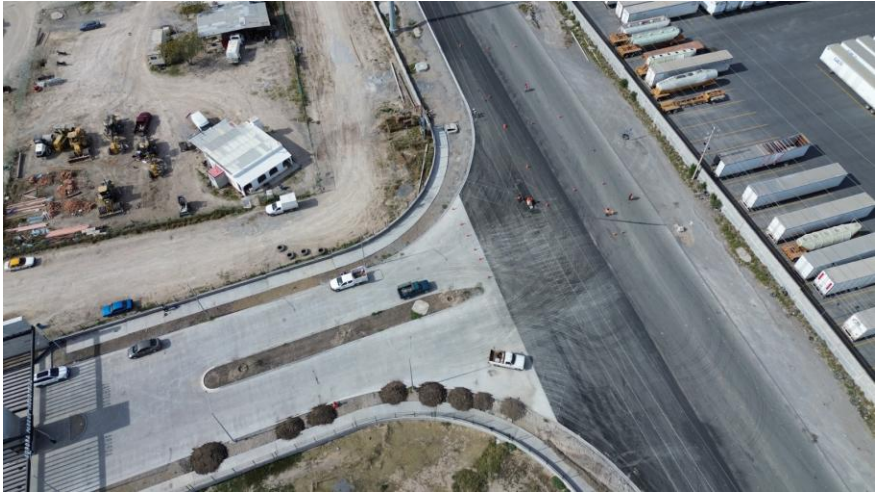
Carpeta asfáltica de carriles exteriores de 7cm de espesor
