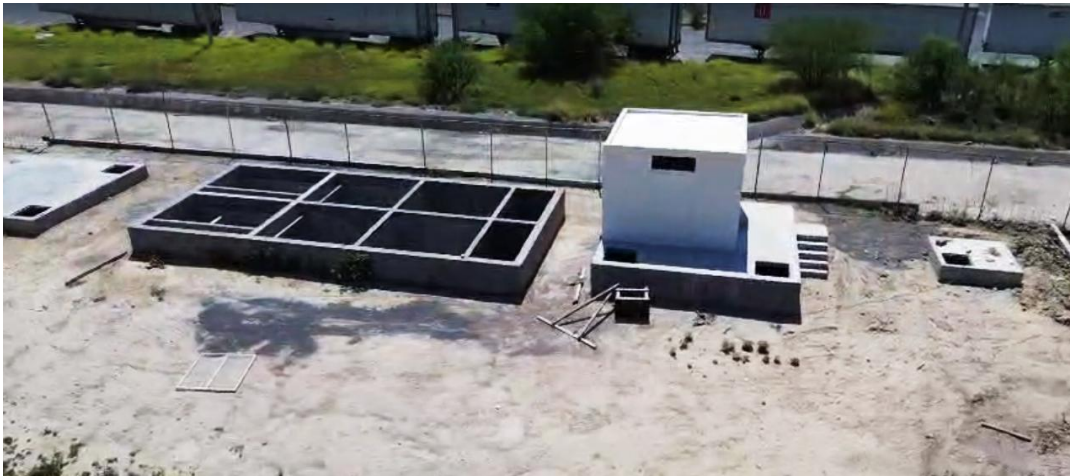
Construcción de Planta de tratamiento de aguas residuales PTAR
