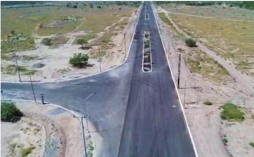
Carpeta asfáltica en calles secundarias y avenida principal interior junto con camellones ajardinados.
