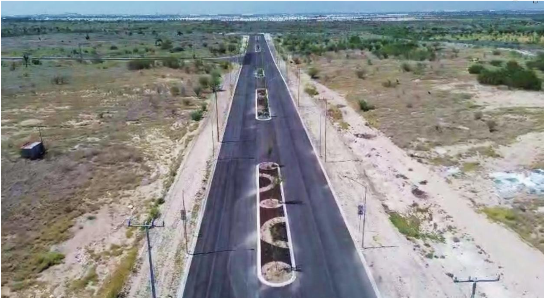
Carpeta asfáltica y camellones ajardinados de avenida principal interior del parque
