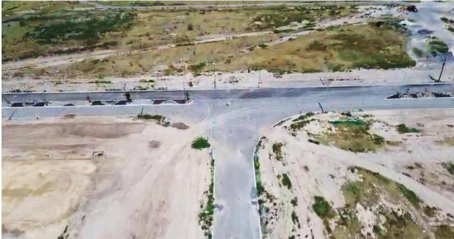
Carpeta asfáltica de calle secundaria y avenida
