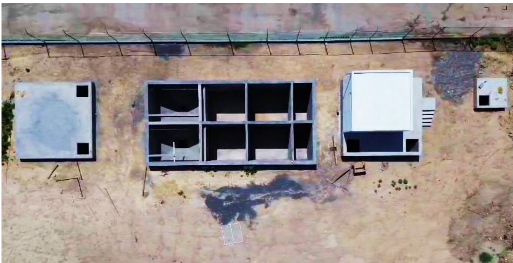
Construcción de planta de tratamiento de aguas residuales PTAR
