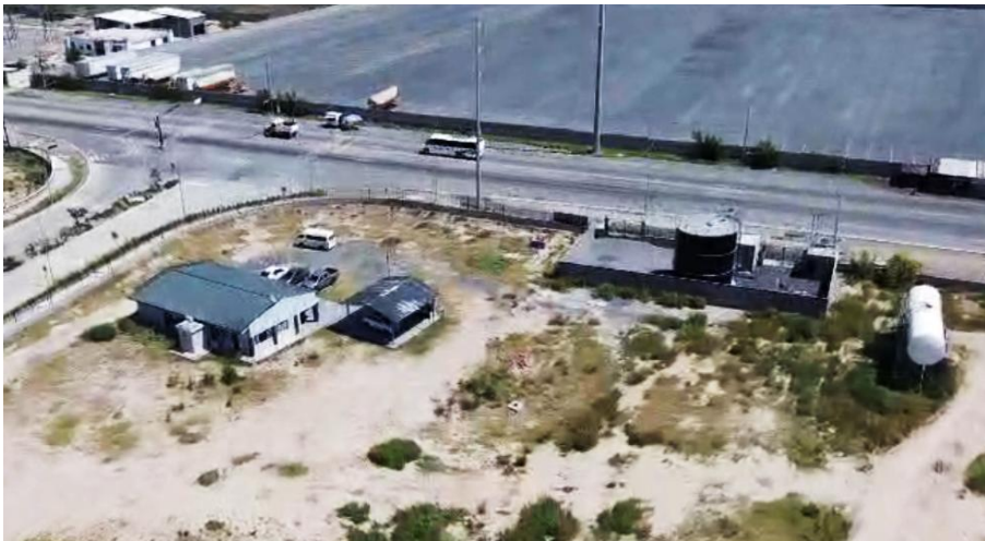
Caseta de ventas y pozo de agua
